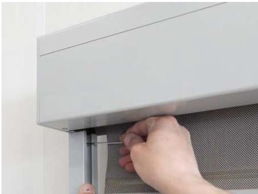
2. Sichern Sie die Kassette durch die Verschrauben.
