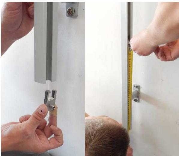
2. Führen Sie das Blockadelement der Arme in die Führungsschiene und ziehen die Schraube davon an der vorher abgemessenen Stelle fest.
