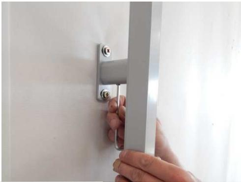
8. Richten Sie die Führungsschiene korrekt aus und ziehen anschließend die Inbusschrauben in den Haltern fest.
