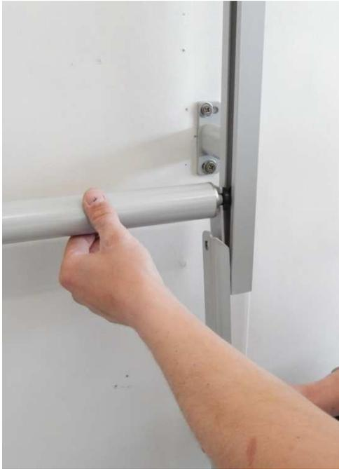
1. Stecken Sie das obere Profil in die dafür vorgesehene Öffnung im Armteil und schieben beide Teile in die Führungsschiene.
